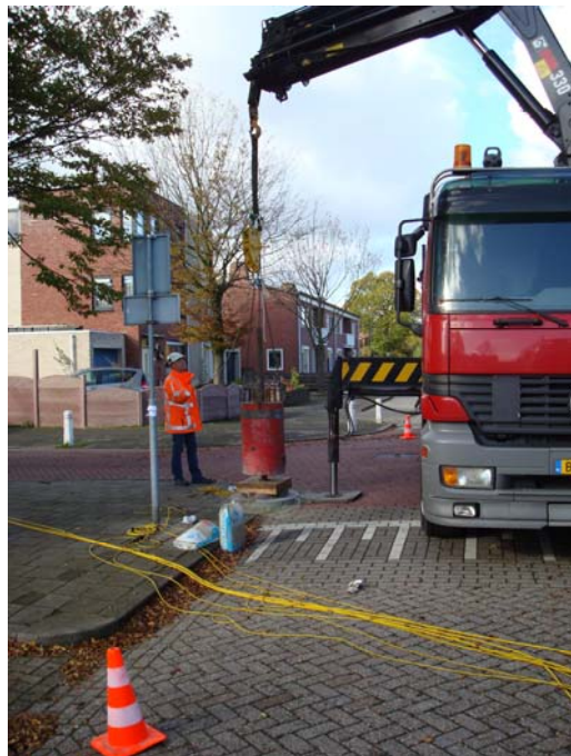
Figuur 1: Het valgewicht wordt gehesen met behulp van een kraan (Willem Zelleweg).
