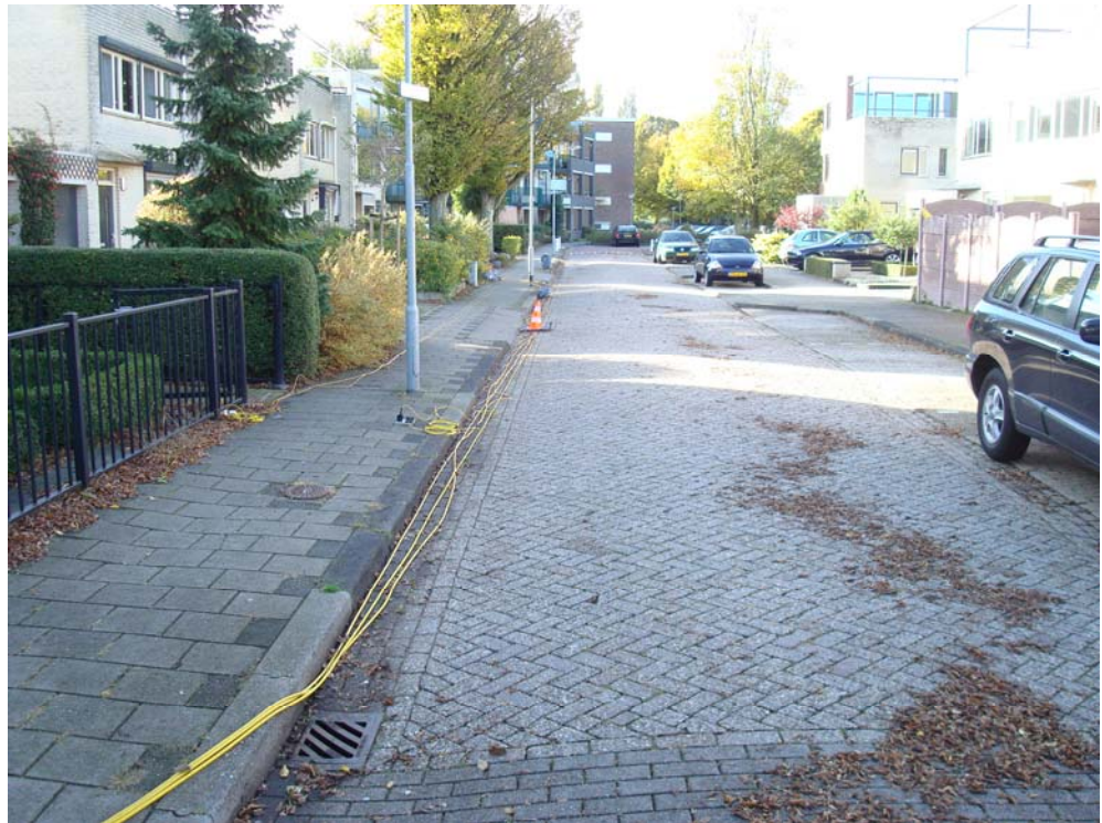
Figuur 2: Bekabeling langs het meetraai (valproef bij Willem Zelleweg).
